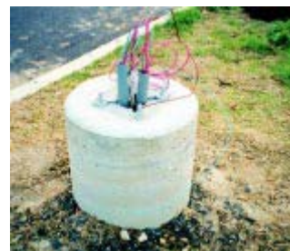
8.6. attēls Elektrokabeļa izvadīšana ārpus pāļa
