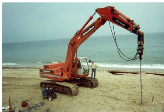
7.6. att. Skrūvpāļu pamatu izveidošana pludmalē
