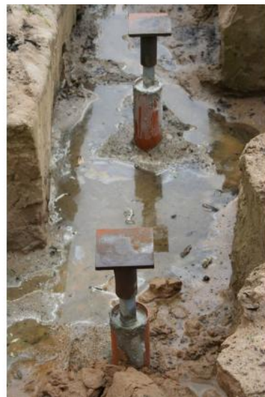
8.2. attēls. Skrūvpāļu pamatu sistēmas zem jaunbūves konstrukcijām
