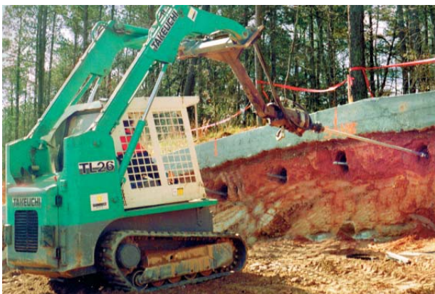
8.13.attēls Skrūvpāļu ieskrūvēšana gruntī, lai nostiprinātu gruntis, kuru virspusē atrodas mežs
