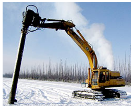
7.7. att. Skrūvpāļu pamatu izveidošana ziemas periodā
