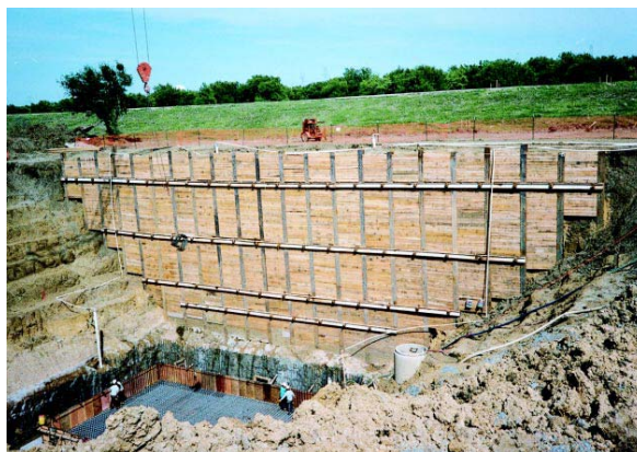
8.14.attēls Rokot dziļu būvbedri, nepieciešams ieskrūvēt skrūvpāļus gruntī, lai nostiprinātu stāvo gruntis masīvu
