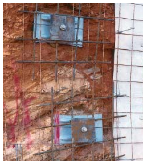
8.17.attēls Nostiprināmajai sienai parasti izveido stiegroto sietu, kuru pēc tam apbetonē
