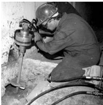
7.4.att. Skrūvpāļu pamatu ieskrūvēšana ar rokās turamu
