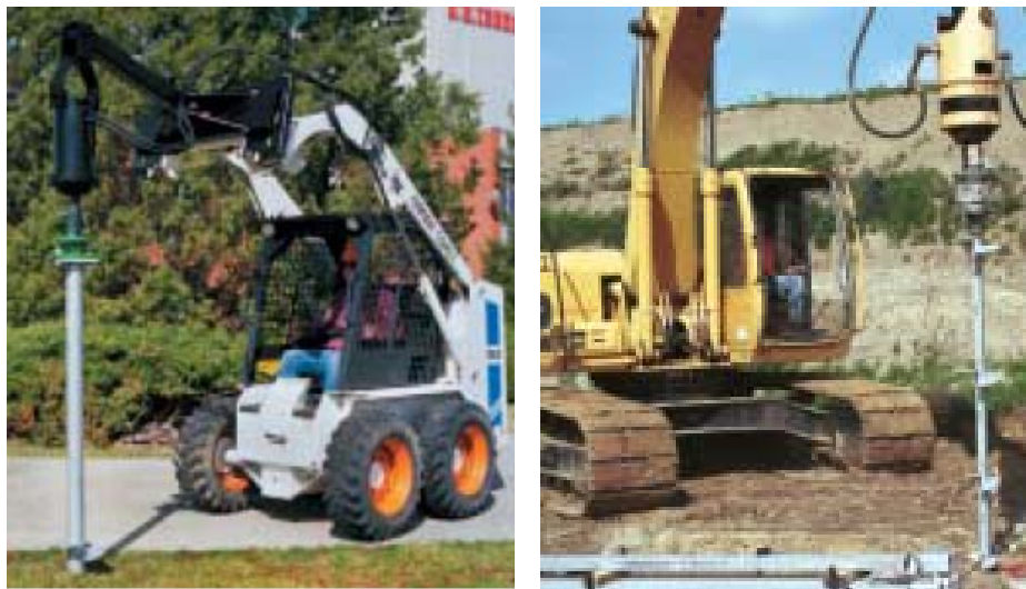
7.5.attēls Skrūvpāļu pamatu izveidošana ar būvmašīnu
