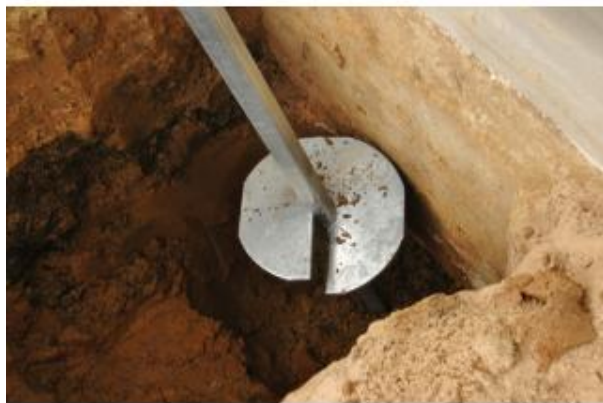
8.8.attēls Tiek izrakta pietiekoši dziļa bedre un pēc projekta atbilstošs skrūvpālis tiek ieskrūvēts
