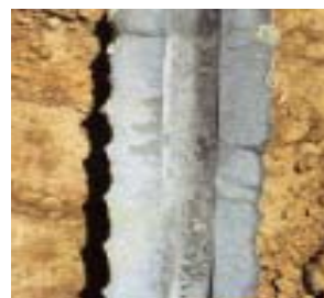
8.10. attēls Nelīdzenas cementa javas kolonnas šķērsgriezums gruntī
