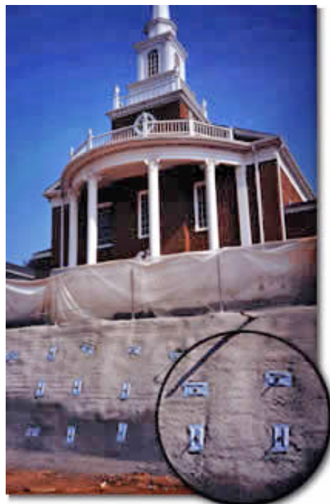
8.15.attēls Rokot būvbedri blakus esošai celtni, tiek nostiprinātu blakus esošās ēkas pamatus un gruntis
