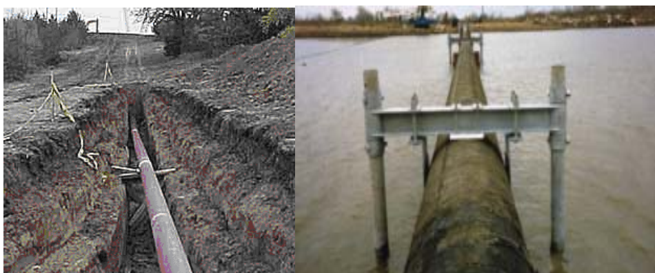
8.19.attēls Cauruļvads, kas nobalstīts uz skrūvpāļiem gruntī un ūdenī
