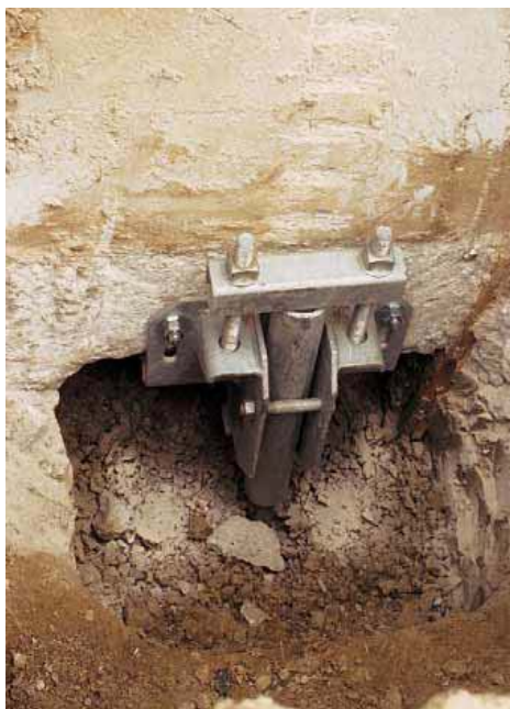
8.7.attēls Ēkas pamati, kas nostiprināti ar skrūvpāli un standarta kronšteinu
